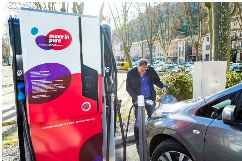
Démarrage d'une charge à la station de Tournon-sur-Rhône
